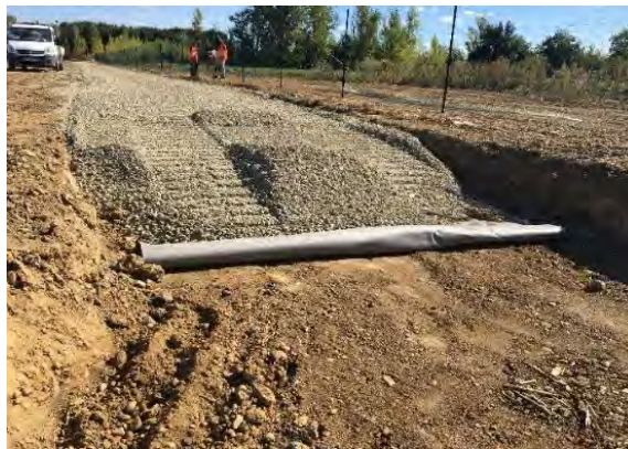
Exemple de réalisation de voie d'accès interne
