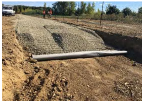
Exemple de création de voie d'accès
